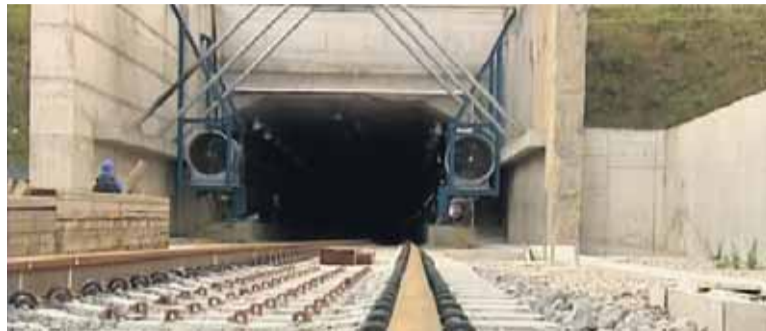
Het leggen van de rails in de Liefkenshoekspoortunnel verloopt voorspoedig.
